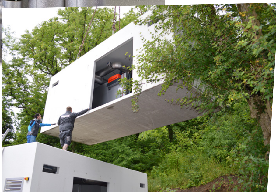
Auslieferung und Aufstellung auf bauseits erstellten Fundamenten.
