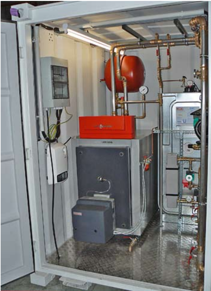
■ Die mobile Heizzentrale beinhaltet alles, was für eine vollwertige Wärmeversorgung eines Gebäudes notwendig ist: Kessel, Öltank, Regelung, Sicherheitsventil, Ausdehnungsgefäß, Manometer, Umwälzpumpe u. v. m.
