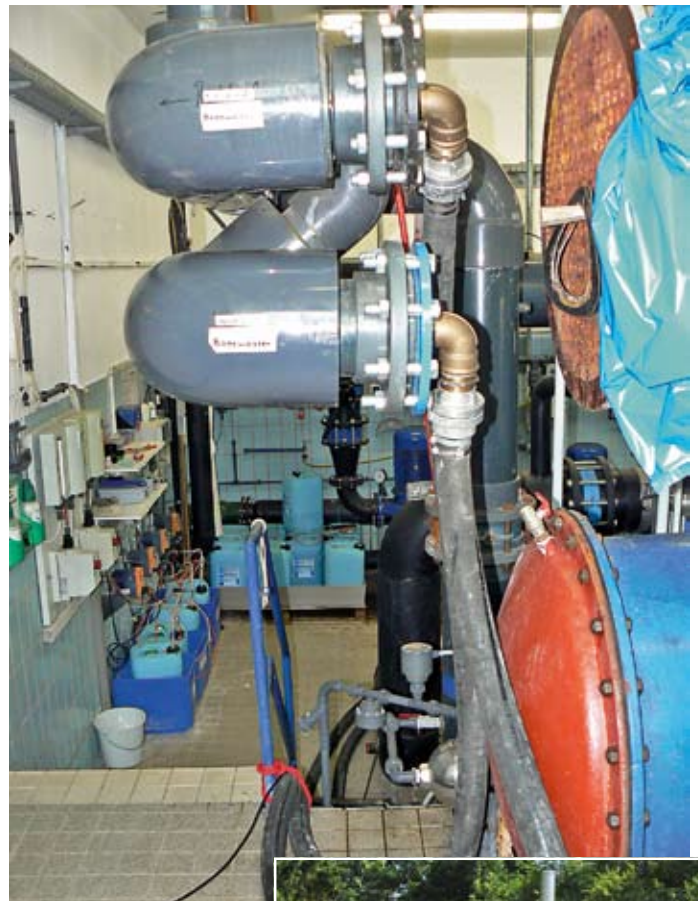
■ Die mobile Heizzentrale – verbunden über Anschluss-schläuche an das Heizsystem des Stadtbades Hornburg.
