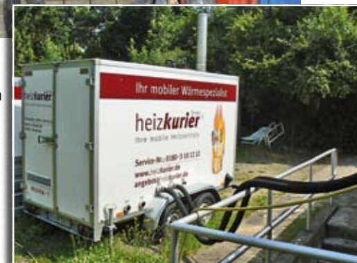
■ Die mobile Heizzentrale – verbunden über Anschluss-schläuche an das Heizsystem des Stadtbades Hornburg.
