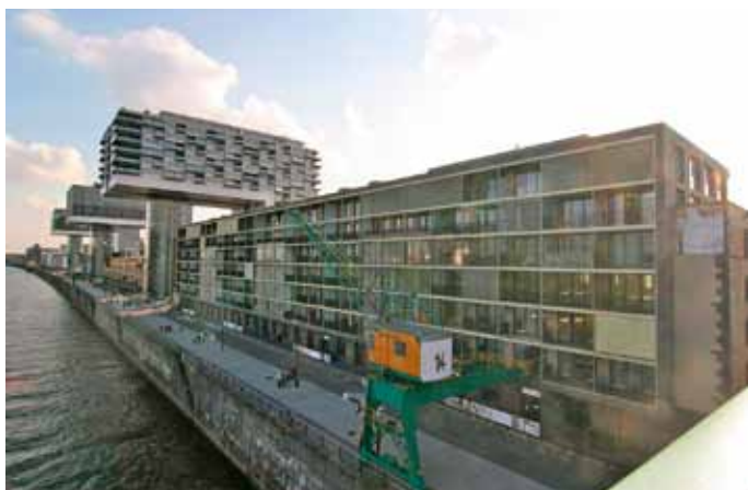
Blick von der Rheinseite auf den Rheinauhafen mit Kranhäusern.
